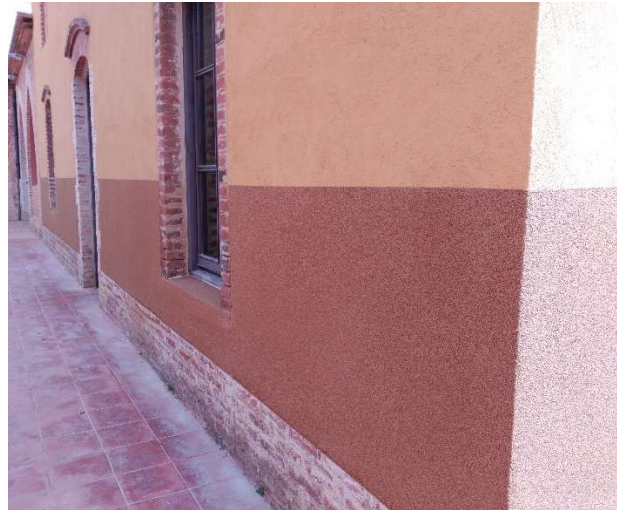
Figura 18. Pared exterior con corcho proyectado. Fuente: ICSuro y Kliucork.
