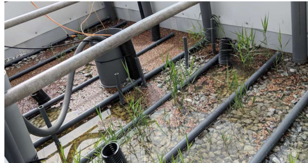
Figura 26. Humedal para el tratamiento de aguas residuales con corcho como material de relleno para la depuración de estas. Font: LifeEcorkwaste.
